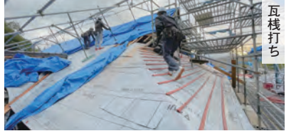
【Gムアス張り】瓦を乗せる下地部分の工事
